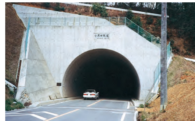
和歌山県農林事務所 小原田トンネル
