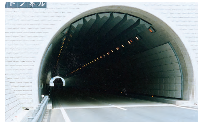
国土交通省 姫路工事事務所 福田トンネル
