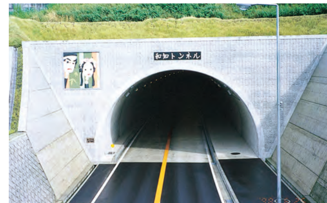
国土交通省 福知山工事事務所
