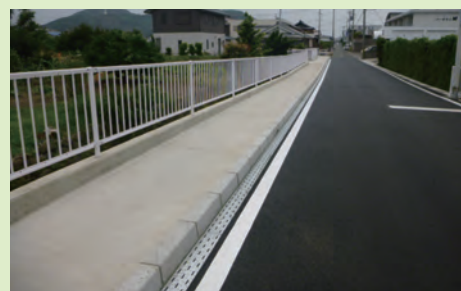
高さ制限のある張り出し歩道
